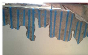
—TRATTAMENTO DEI FERRI CON MALTA CEMENTIZIA ANTICORROSIONA.
