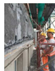
—RICOSTRUZIONE CON MALTA TIXOTROPICA FIBRORINFORZATA
