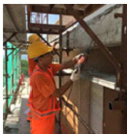
—SPICCONATURA DEL CALCESTRUZZO AMMALORATO
